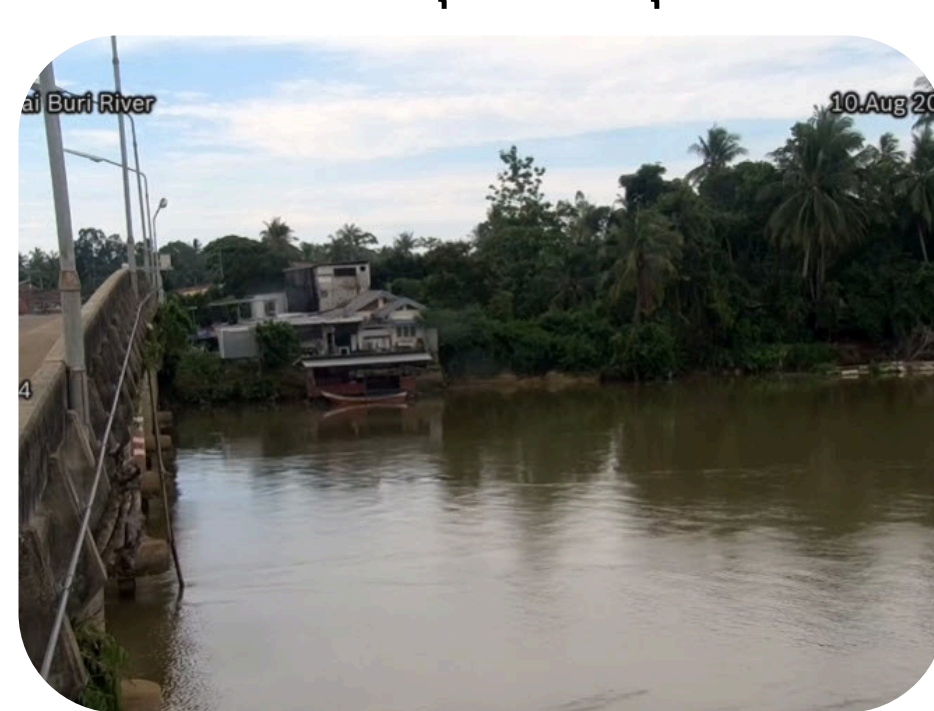
4157-แม่น้ำสายบุรี อ.สายบุรี จ.ปัตตานี
