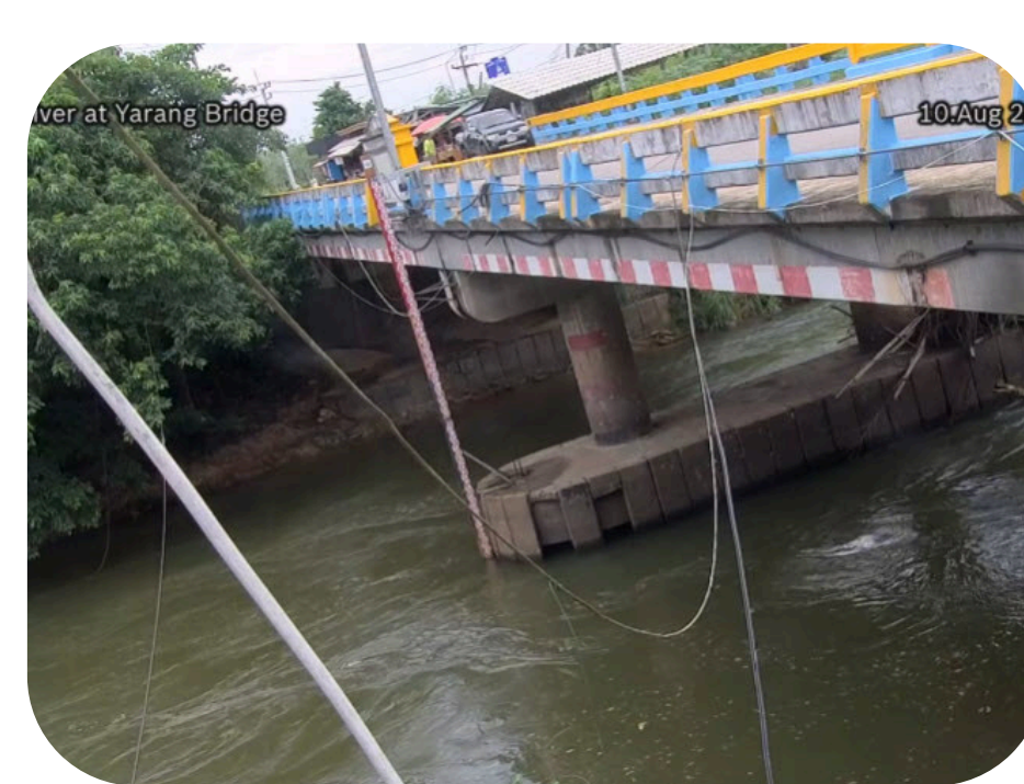
สะพานข้ามแม่น้ำปัตตานี ที่ยะรัง อ.ยะรัง จ.ปัตตานี
